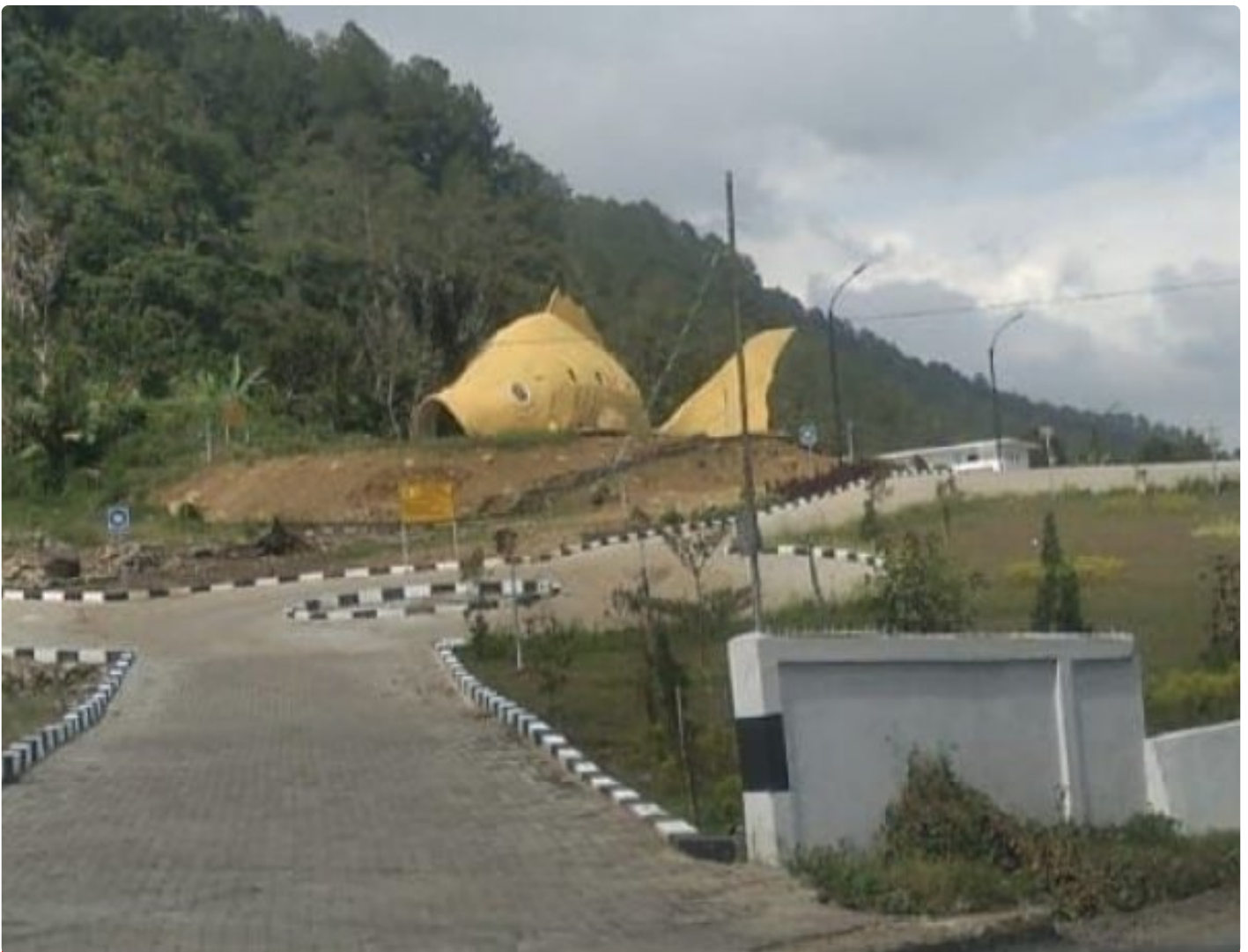
Proyek Pembangunan Ikan Mas Sipolha
